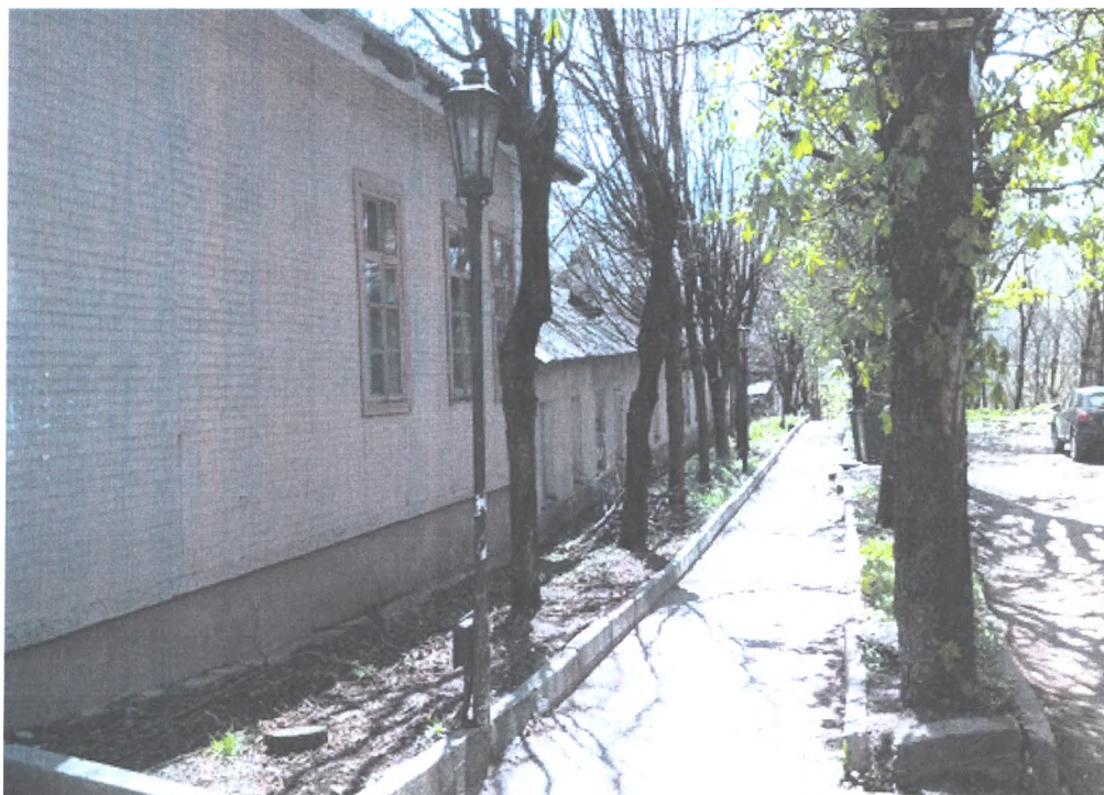
Фото 7. Объект культурного наследия федерального значения «Подворье Карповых, где Лермонтов Михаил Юрьевич провел последнюю ночь перед дуэлью», 1841 г., Ставропольский край, г. Железноводск, ул. Семашко, 9/11. Главный фасад (литер Б).
