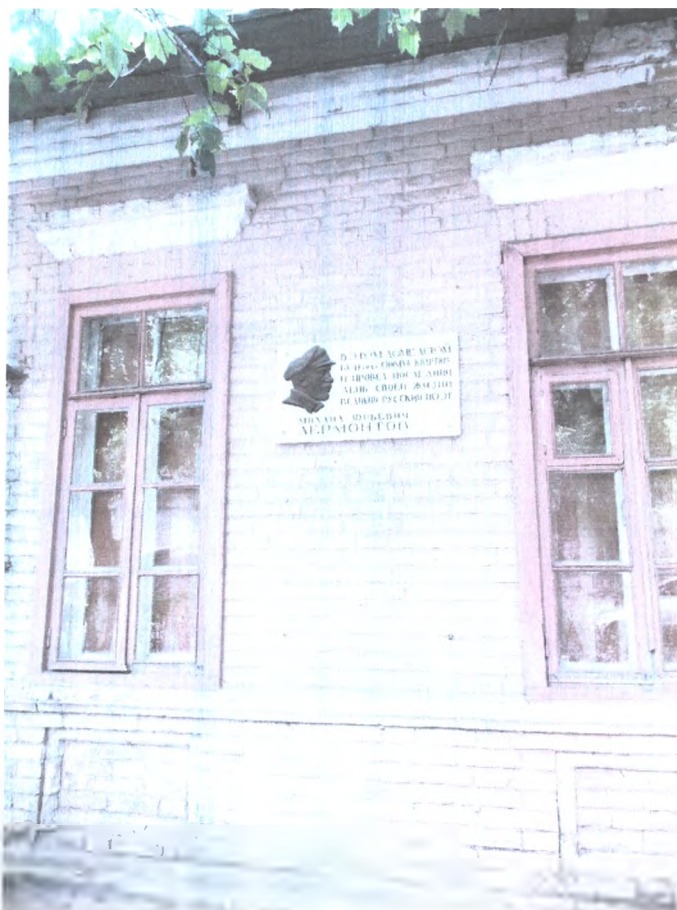
Фото 20. Объект культурного наследия федерального значения «Подворье Карповых, где Лермонтов Михаил Юрьевич провел последнюю ночь перед дуэлью», 1841 г., Ставропольский край, г. Железноводск, ул. Семашко, 9/11. Фрагмент главного фасада (литер Г).
