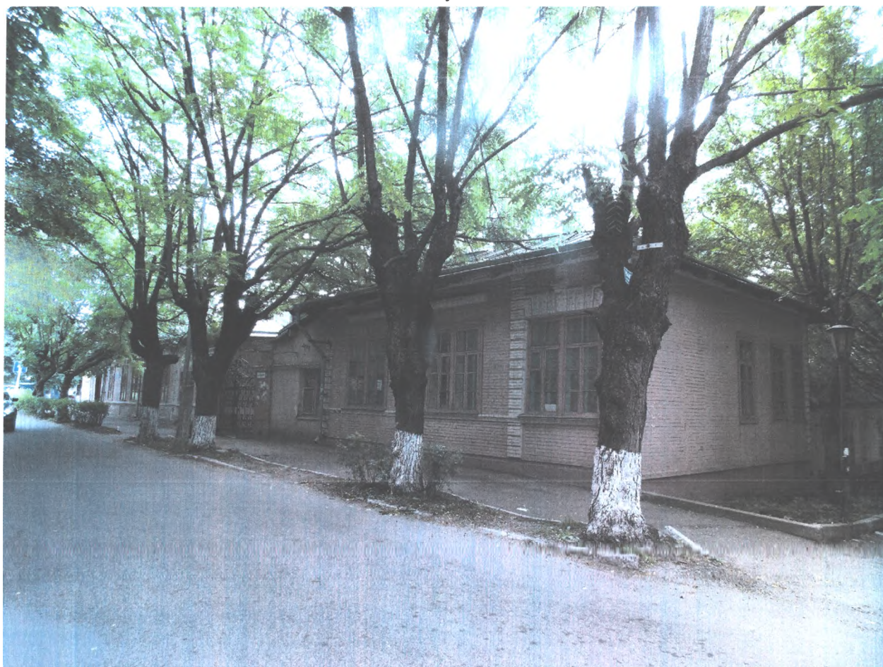
Фото 1. Объект культурного наследия федерального значения «Подворье Карповых, где Лермонтов Михаил Юрьевич провел последнюю ночь перед дуэлью», 1841 г., Ставропольский край, г. Железноводск, ул. Семашко, 9/11. Общий вид с ул. Семашко (литеры В, Г).
