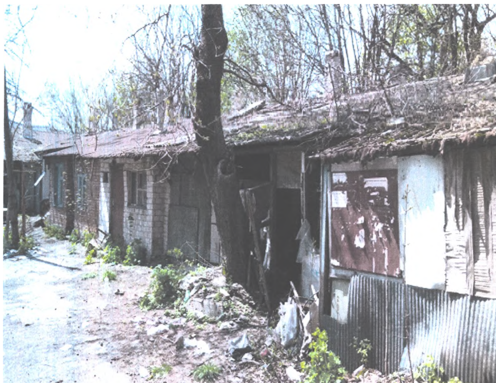
Фото 8. Объект культурного наследия федерального значения «Подворье Карповых, где Лермонтов Михаил Юрьевич провел последнюю ночь перед дуэлью», 1841 г., Ставропольский край, г. Железноводск, ул. Семашко, 9/11. Дворовый фасад (литер Б).
