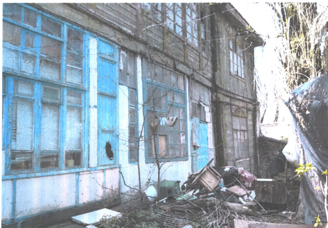
Фото 3. Объект культурного наследия федерального значения «Подворье Карповых, где Лермонтов Михаил Юрьевич провел последнюю ночь перед дуэлью», 1841 г., Ставропольский край, г. Железноводск, ул. Семашко, 9/11. Состояние главного фасада (литер А).
