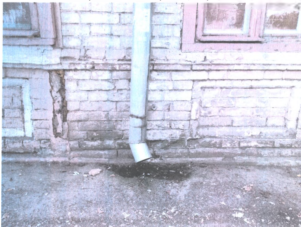
Фото 21. Объект культурного наследия федерального значения «Подворье Карповых, где Лермонтов Михаил Юрьевич провел последнюю ночь перед дуэлью», 1841 г., Ставропольский край, г. Железноводск, ул. Семашко, 9/11. Состояние цоколя, отмостки (литер Г).
