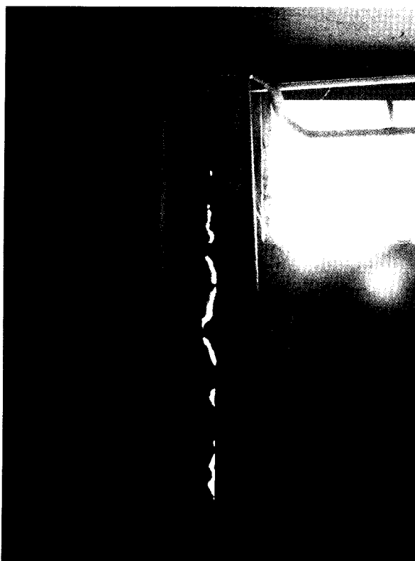
Фото 10. Объект культурного наследия федерального значения «Подворье Карповых, где Лермонтов Михаил Юрьевич провел последнюю ночь перед дуэлью», 1841 г., Ставропольский край, г. Железноводск, ул. Семашко, 9/11. Сквозная трещина в северо-восточном углу.
