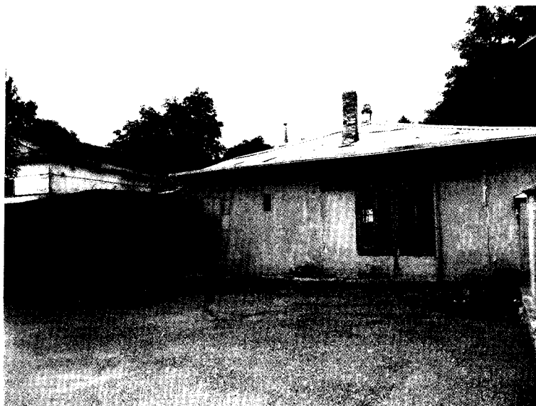
Фото 6. Объект культурного наследия федерального значения «Подворье Карповых, где Лермонтов Михаил Юрьевич провел последнюю ночь перед дуэлью», 1841 г., Ставропольский край, г. Железноводск, ул. Семашко, 9/11 Восточный фасад.
